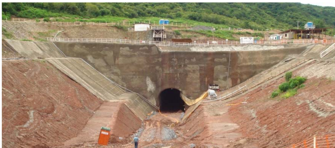
Figura 4 - Taludes do canal revestido com concreto projetado
