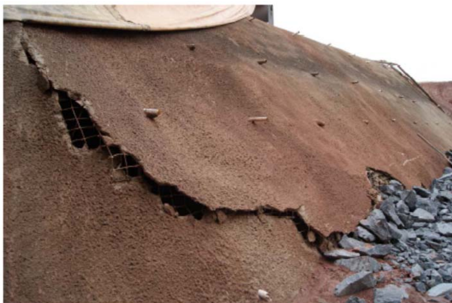
Figura 5 - Pé do talude direito junto ao emboque, após deslizamento lento do revestimento.
