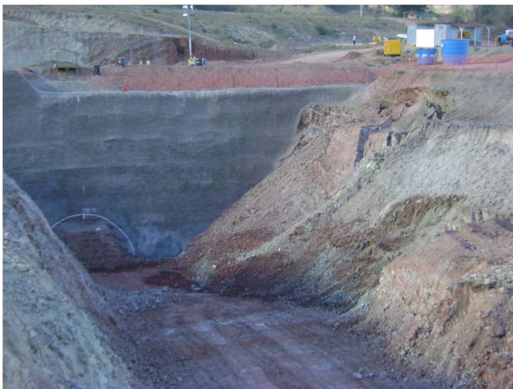
Figura 1 - Talude lateral instável próximo ao emboque do Túnel Cuncas I
